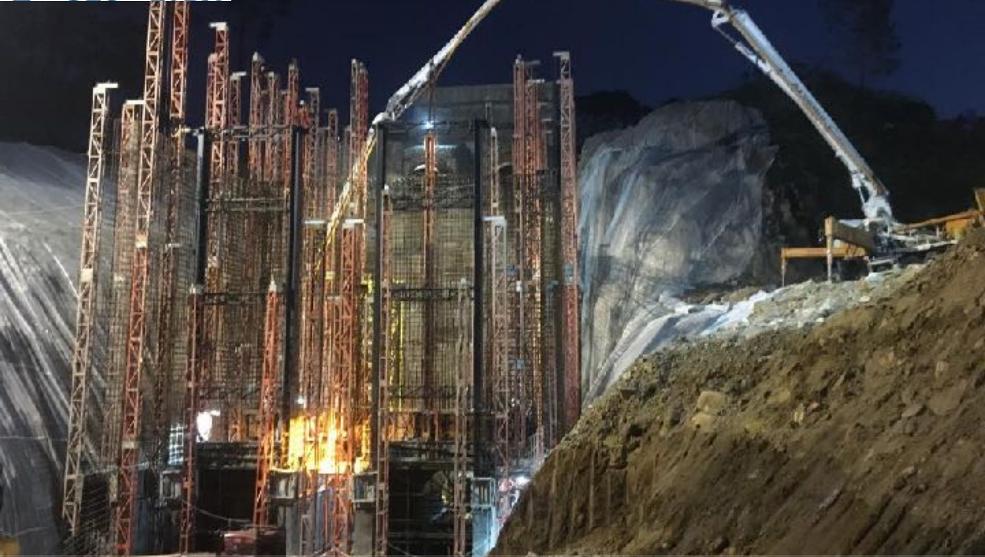
CASA DE FORÇA CONCRETAGEM DO CASCO COM FORMAS DESLIZANTES: INICIO DIA 08/09
