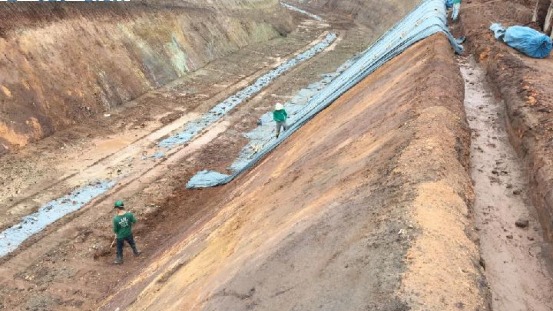
CANAL ADUTOR INICIADA A APLICAÇÃO DE BIDIM NOS TALUDES DO CANAL
