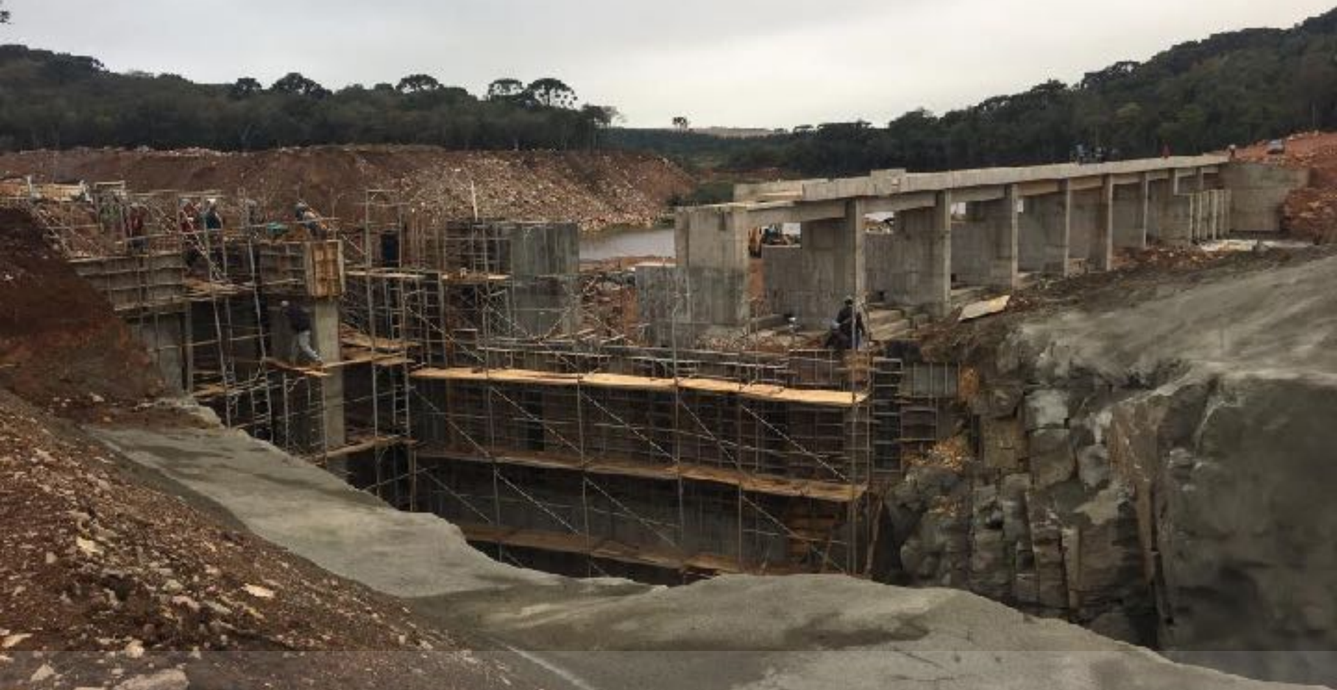
BARRAGEM VISTA DE JUSANTE DA TOMADA D'ÁGUA E INÍCIO DO CANAL
