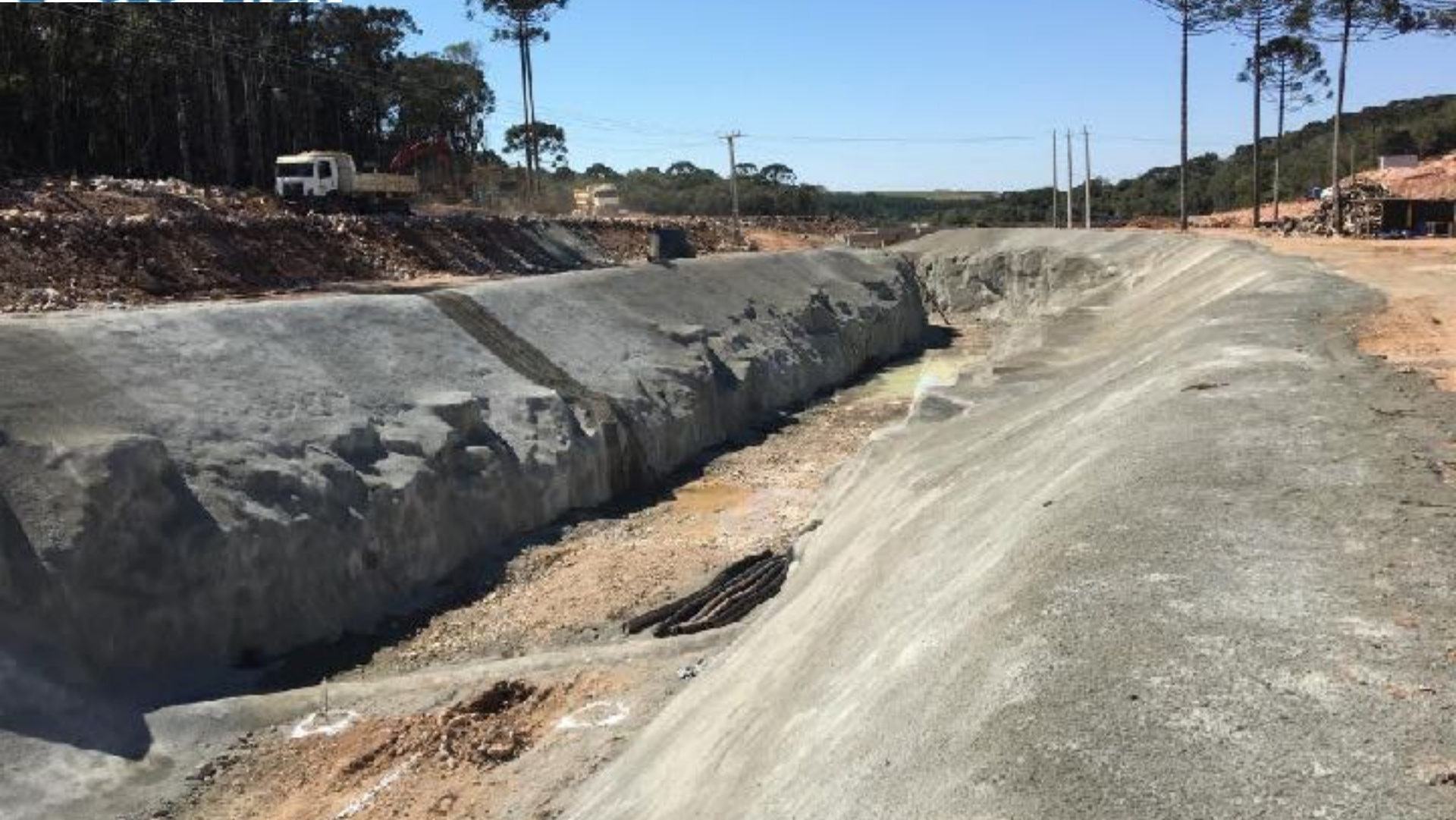
CANAL ADUTOR TRECHO EM ROCHA ENTRE ESTACAS 0 A 10 TRATAMENTO EM CONCRETO PROJETADO FINALIZADO
