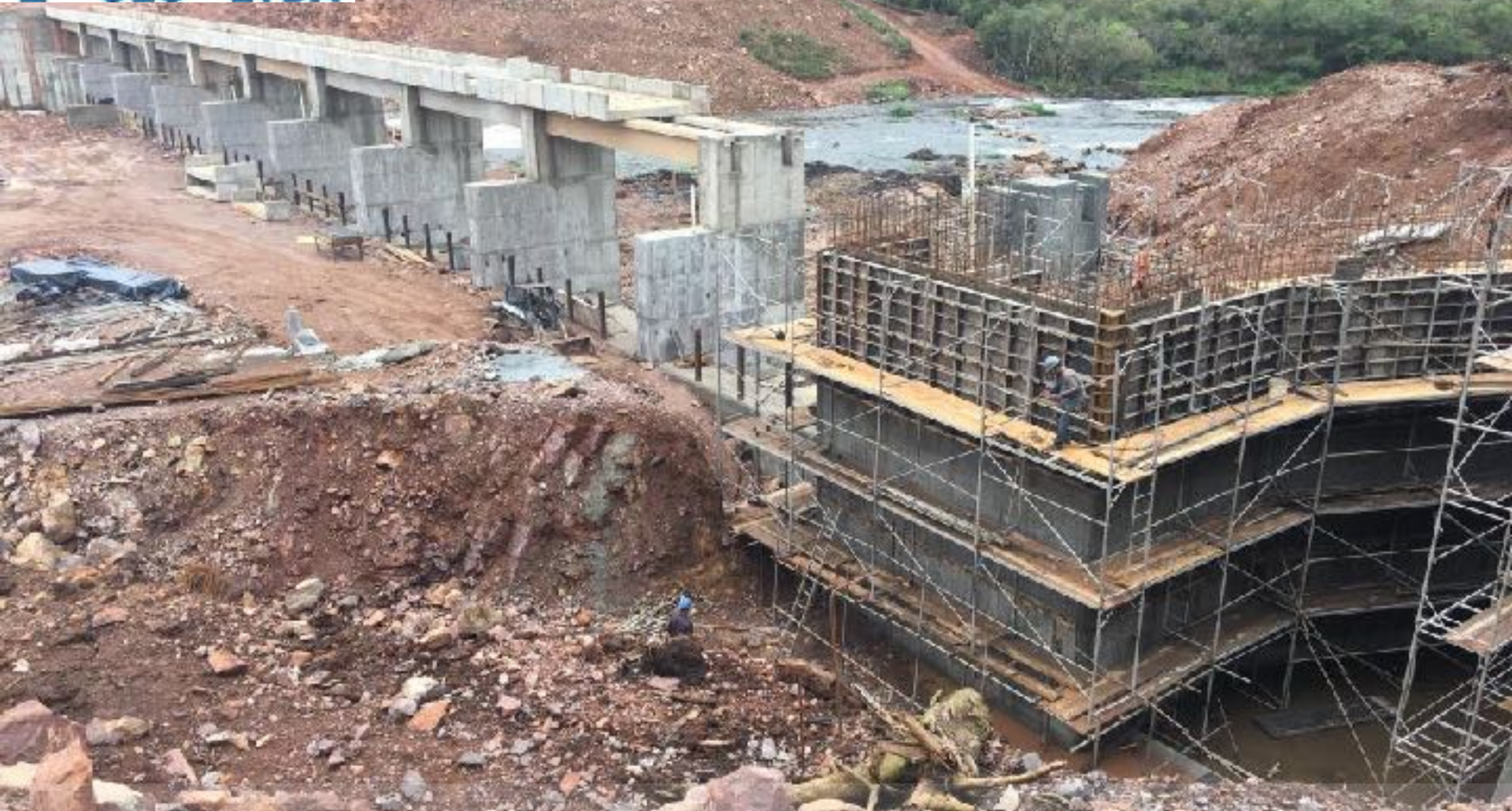
BARRAGEM EM EXECUÇÃO MONTAGEM DOS TABULEIROS
