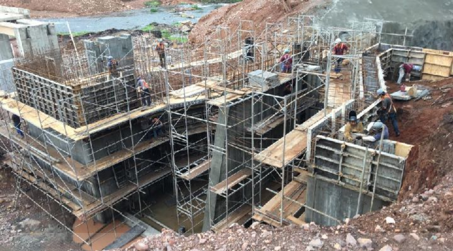
TOMADA D'ÁGUA ELEVAÇÃO DAS PAREDES
