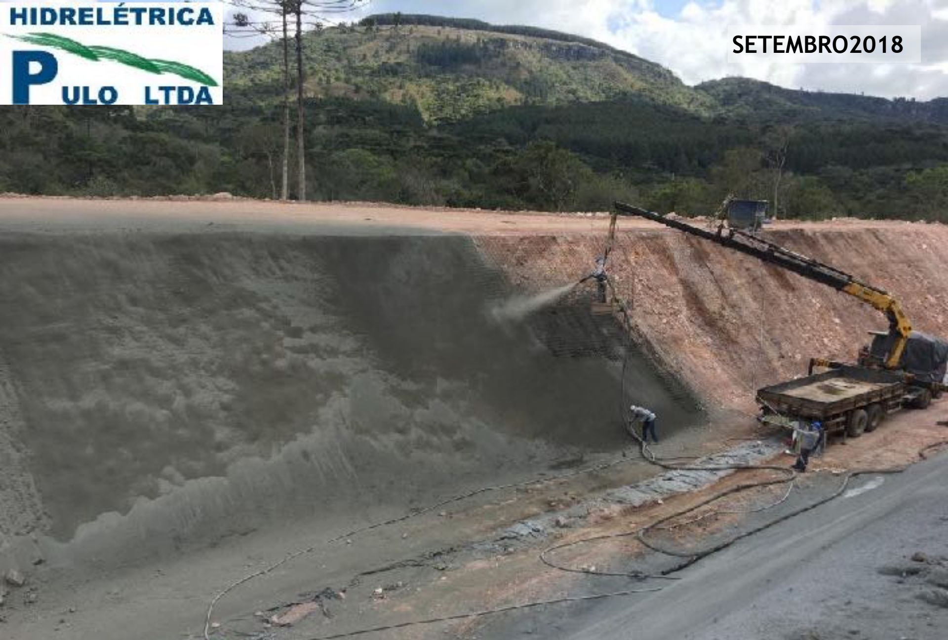
CANAL ADUTOR CONCRETO PROJETADO ENTRE ESTACAS 18 A 20
