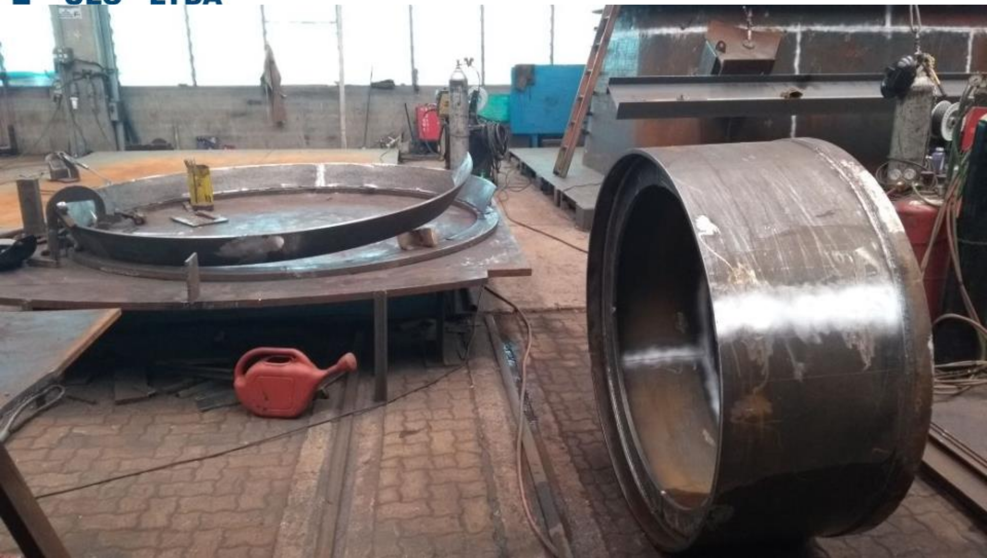
TURBINAS PRÉ-DISTRIBUIDOR M2
