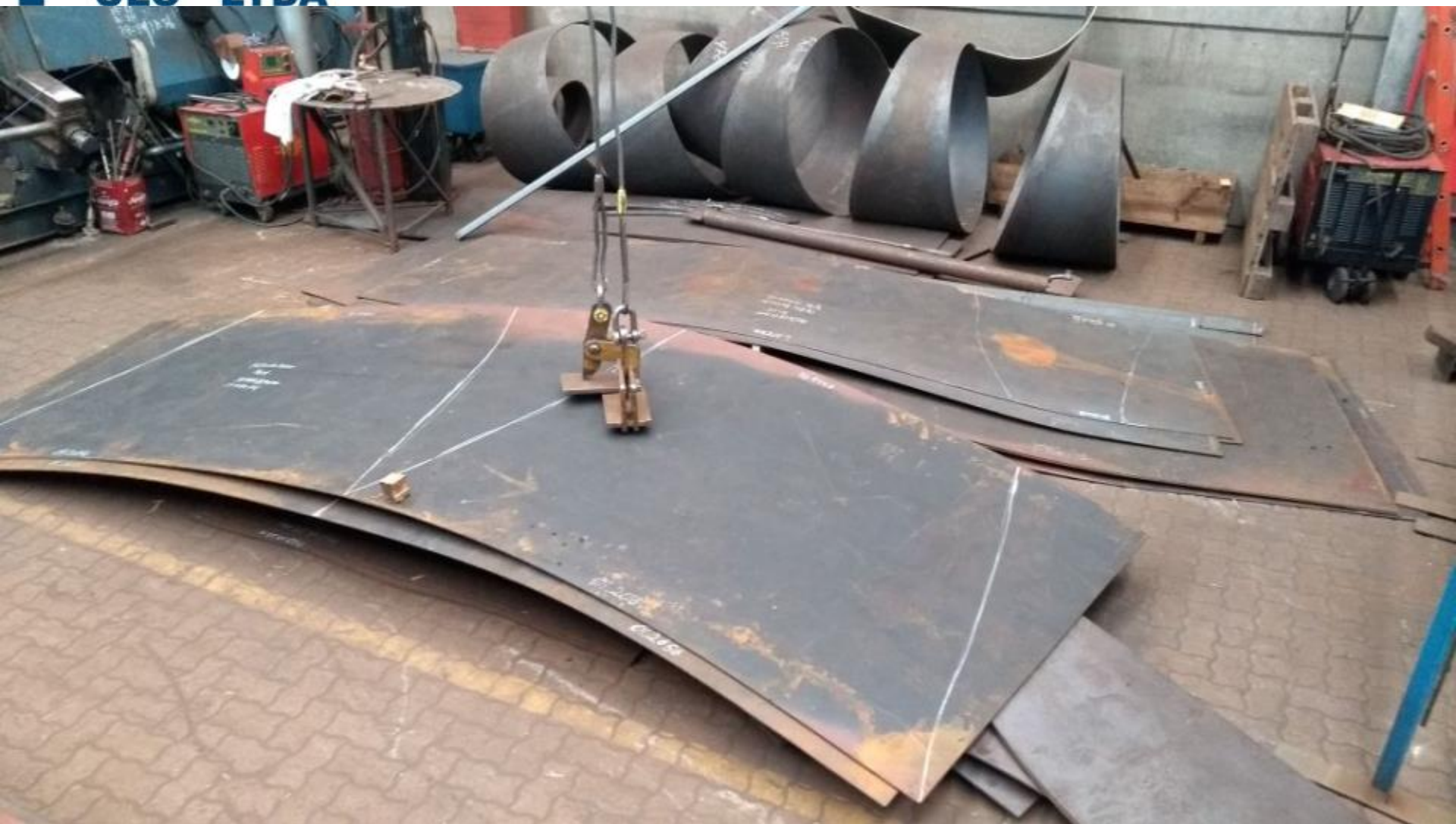
TURBINAS CHAPAS DO FINAL DA SUCÇÃO, REVESTIMENTO DO CONCRETO
