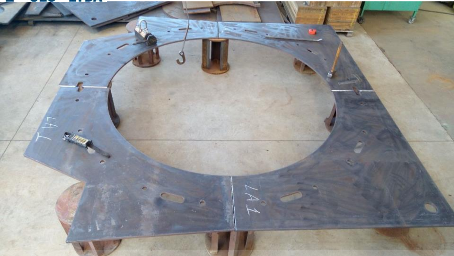
GERADORES MONTAGEM DA CARÇAÇA M1 E M2
