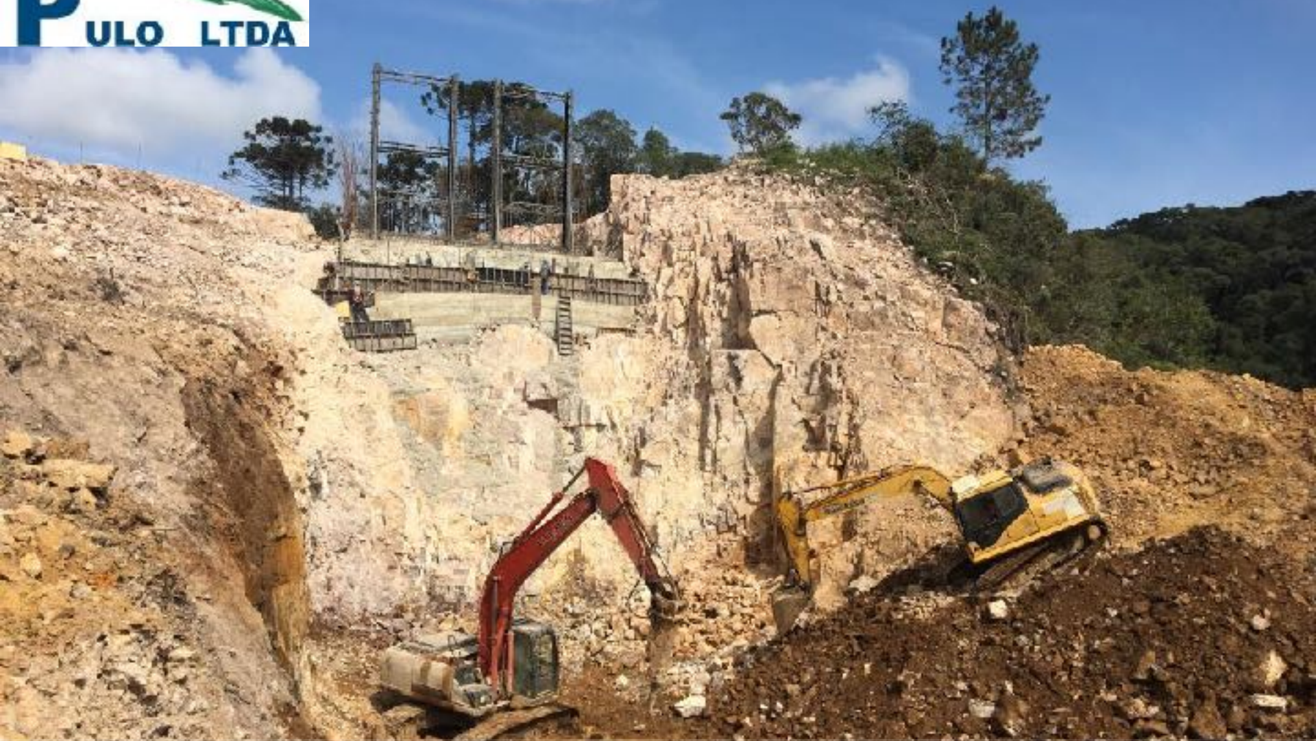
CASA DE FORÇA ESCAVAÇÕES EM ROCHA RETOMADAS
