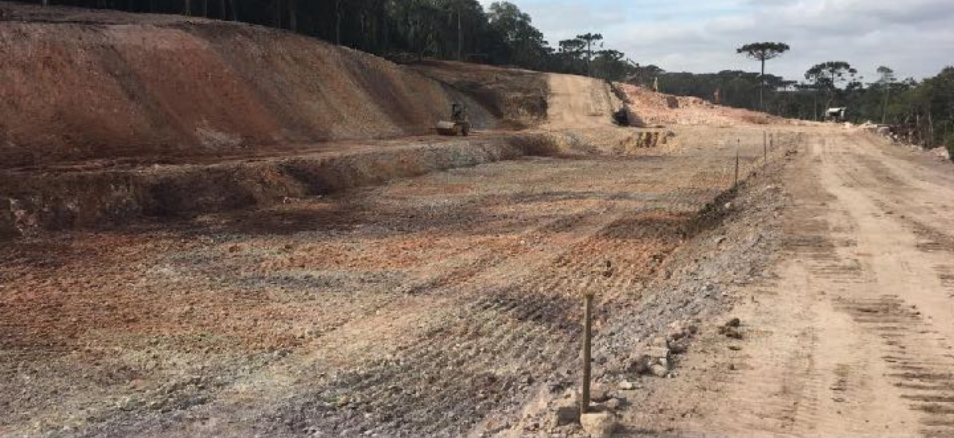
CANAL ADUTOR FRENTE ARENA - INICIADO O CORTE DA SEÇÃO TÍPICA DO CANAL ENTRE AS ESTACAS 20 A 40 (ULTIMA)
