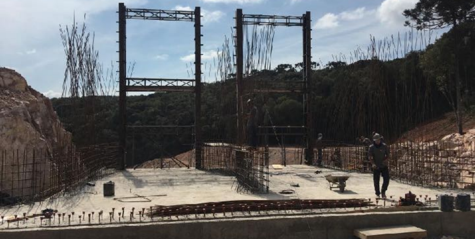
CÂMARA DE CARGA LAJE DE FUNDO CONCRETADA, GUIAS DAS COMPORTAS MONTADAS E INÍCIO DAS ARMADURAS DAS PAREDES EM ANDAMENTO
